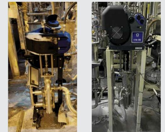
결빙은 공기 공급 라인의 수분이 응결되어 공압 제어 장치에 얼어붙을 때 발생합니다. 축적된 얼음이 재료 용기에 녹아들면 오염 문제가 발생할 수 있습니다. 녹은 얼음이 공장 바닥에 떨어지면 안전 위험 요소가 됩니다.
